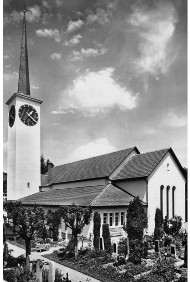
Kirche nach dem Umbau 1939
