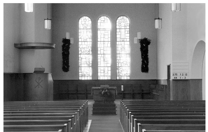
Kirche innen nach dem Umbau 1939
