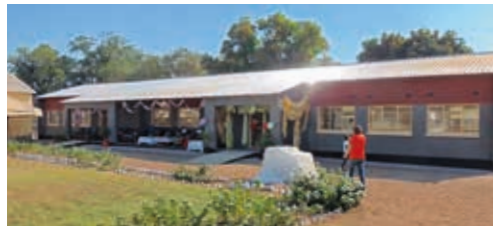
Schulhausblock mit drei Schulzimmern, Bibliothek und Lehrerzimmer
